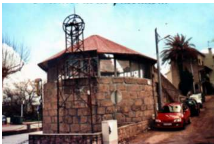
Imagem 2: o Engenho, vista lateral (cortesia Foto Ribeiro)
